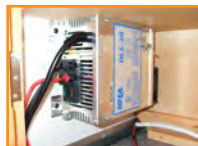
バッテリーチャージャー
